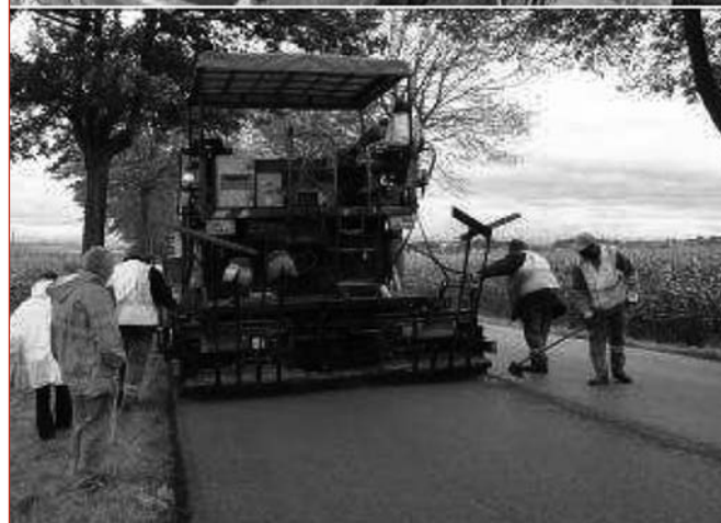
Photos 8 et 9 : Chargement d'un camion à la centrale de fabrication mise en œuvre des enrobés correspondants sur une route départementale très circulée.
