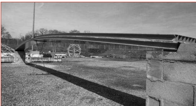
Figure 14 : Vue d'ensemble de la passerelle.
