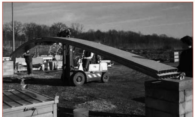
Figure 11 : Positionnement de la poutre dans sa position finale.
