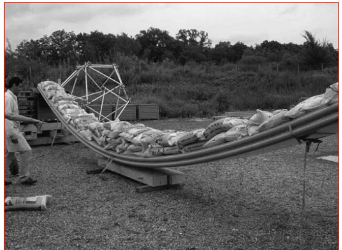
Figure 10 : Collage des poutres.
